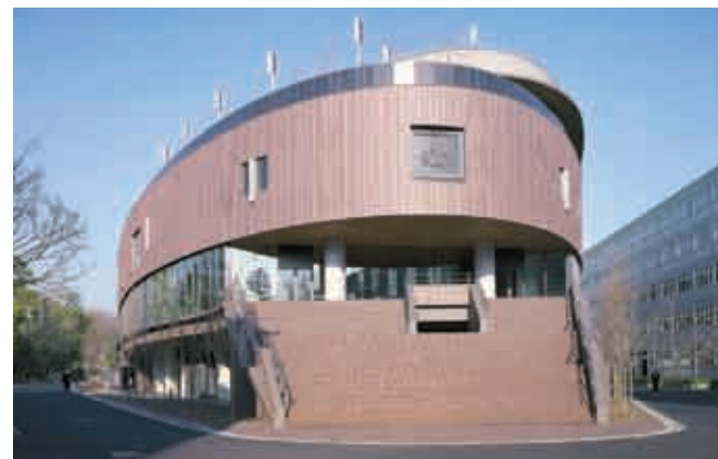
記念事業「総合学生会館 メディアパーク 凜風館」 平成18年2月竣工
