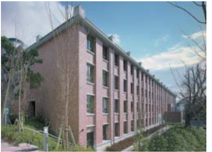
新館部分が完成した以文館
