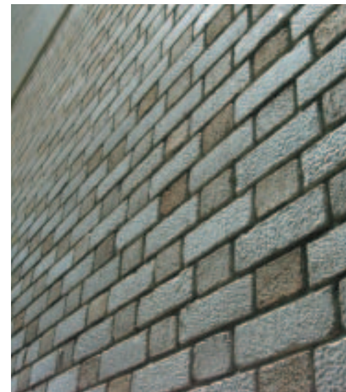
第4学舎1号館。壁面の微妙な凹凸が柔らかなさを生み出す。
