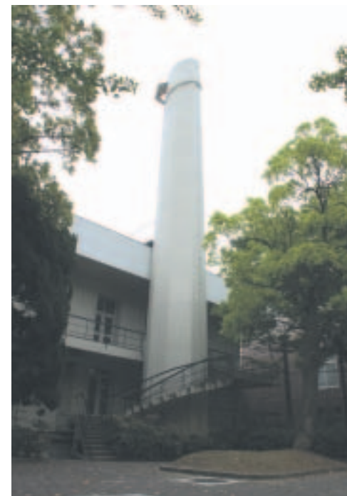
第1学舎1号館西端の煙突。対称性のない八角形で、紙の上だけではデザインできない形態である。
