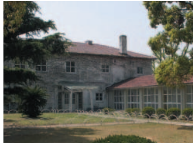
解体前の旧大学ホールと簡文館に移設されたガラスの庇
