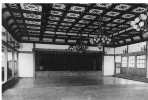
威徳館の内部
